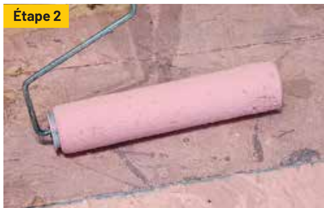
Étendre le Okatmos DSG sur les substrats de béton ou de bois...
