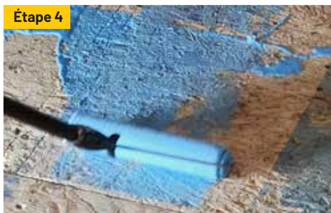
Kiesel recommande l'utilisation d'un apprêt. Il améliore la performance et l'adhésion des mortiers.
