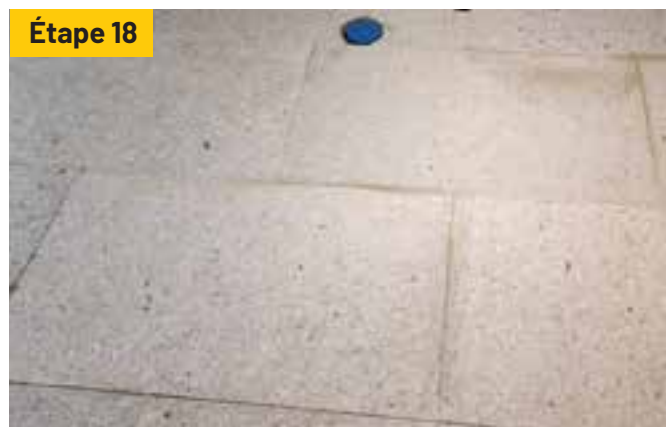
Exemple d'une installation terminée. Pour l'installation de l'insonorisation, recouvrir tous les joints avec du ruban de masquage de 3/4 po avant la pose des carreaux.
