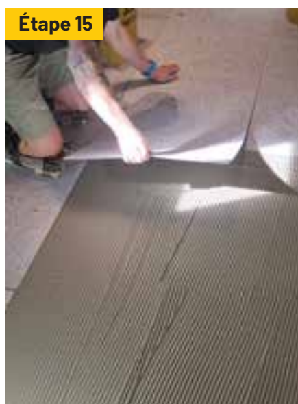
Incorporer l'OkaQuiet dans le mortier frais en nettoyant le mortier bombé entre les panneaux.
