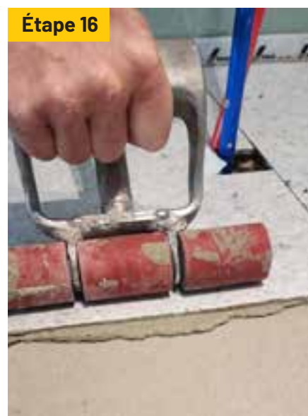
Utiliser des rouleaux d'enrobage manuels ou larges ou des truelles plates pour obtenir un transfert de mortier à 100 %.
