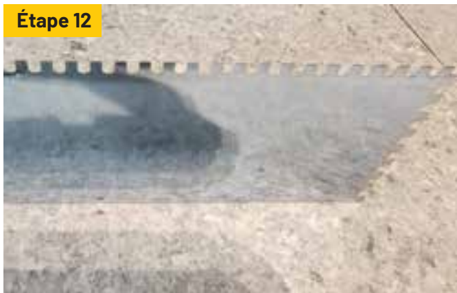
Utiliser une truelle à dents carrées 1/4 po x 1/4 po x 1/4 po pour installer le OkaQuiet.
