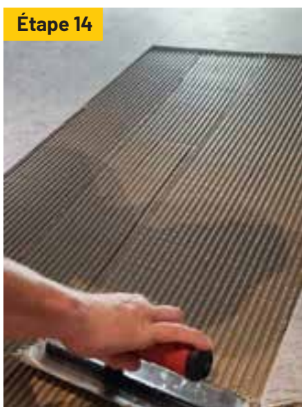
Étaler le mortier dans un sens en gardant les rebords élevés.
