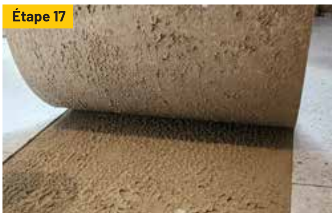
Soulever le panneau OkaQuiet à l'occasion pour vérifier si la couverture est appropriée.
