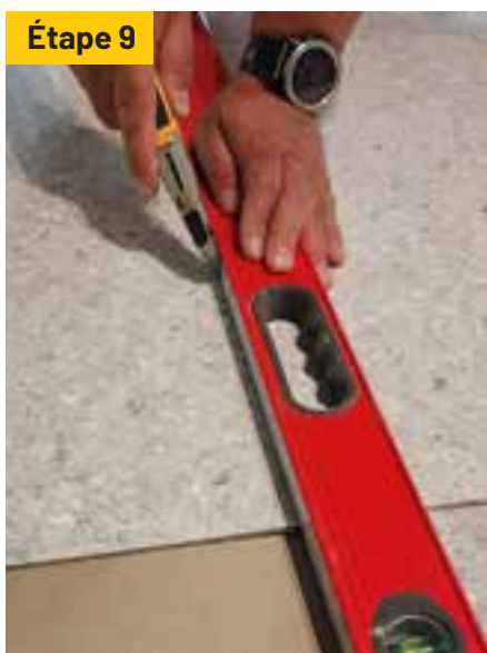
Effectuer des entailles dans le OkaQuiet avec un couteau à placoplâtre.
