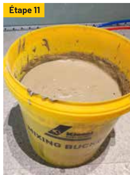
Mélanger le Servoflex 5 le Servoflex-Trio-SuperTec ou Servoflex Pro selon les ratios appropriés.
